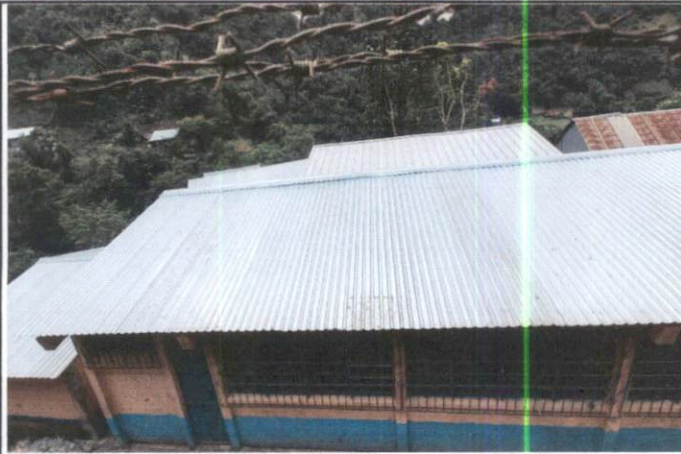
Foto1: Instalación de lamina troquelada calibre 26
