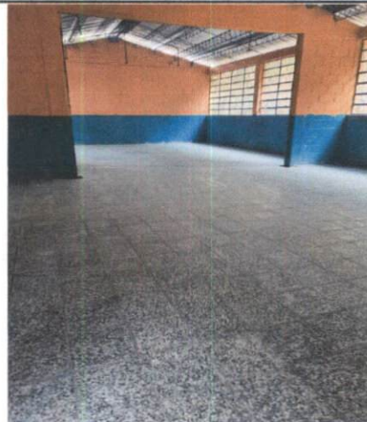
Foto 2: Mejoramiento del piso
